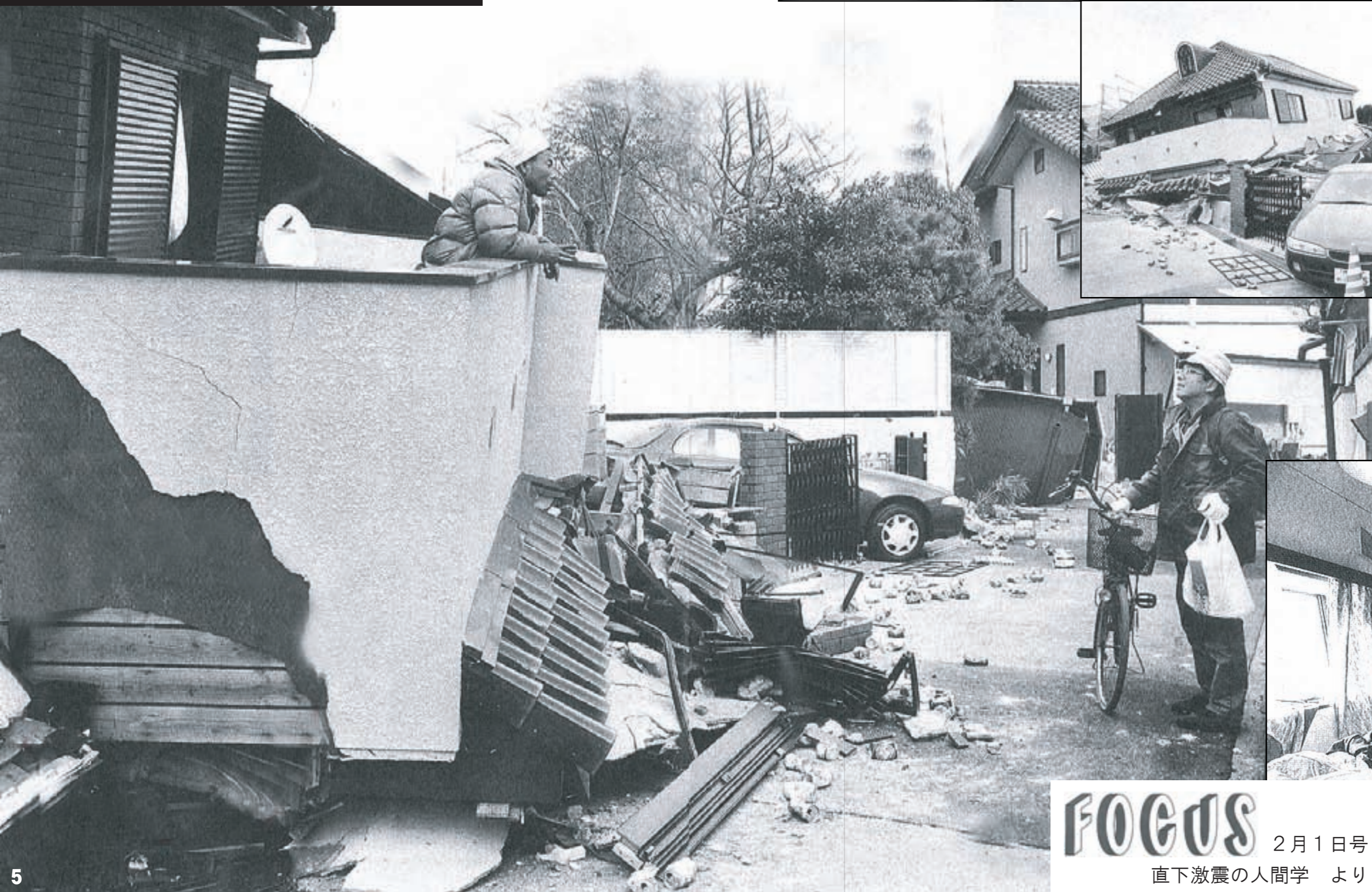
阪神大震災で崩壊してしまった、建てたばかりの家
